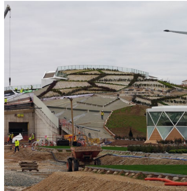
FIG 05. Fotografía del proceso de construcción [José Hevia]. Photography of the construction process.
